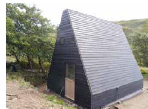
Ci-contre, en haut : le prototype de la A-Barn en Écosse, en cours de montage.
