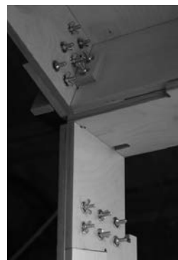
Les assemblages boulonnés du prototype de Gwanjiu.
